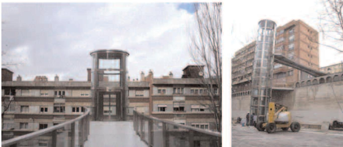
Con el objeto de dotar a todas las actuaciones mediante sistemas mecánicos para salvar barreras arquitectónicas repartidas por la ciudad de una misma imagen, que permitan identificarlas de forma sencilla y que faciliten la comunicación con el exterior a las personas sordas, se ha optado por construir un ascensor panorámico albergado en un cilindro de vidrio formado por una estructura metálica revestida de acero inoxidable y vidrios curvos.
