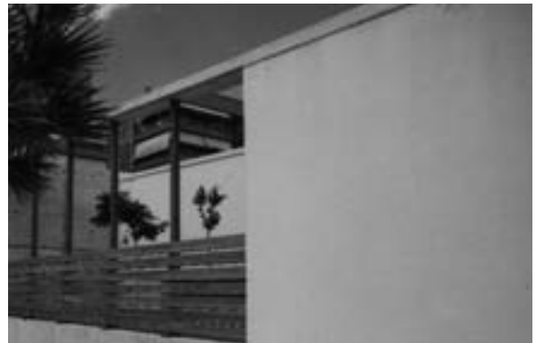
Vista de la tanca exterior del centre.
