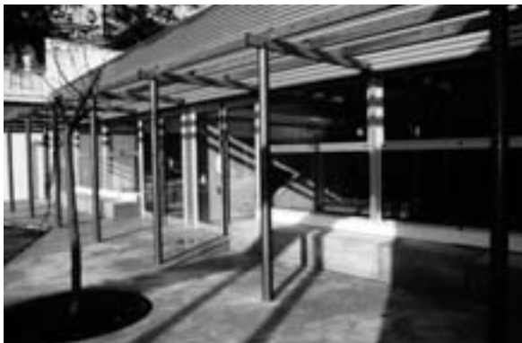
Vista de la porxada exterior de protecció.
