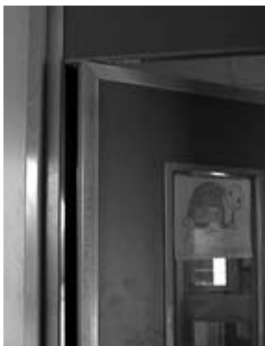
Dispositiu per evitar enganxar-se els dits a les portes.
