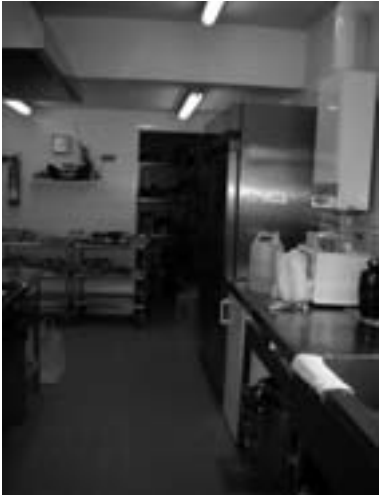
Aspecte d'una cuina de tipus industrial d'una escola bressol.
