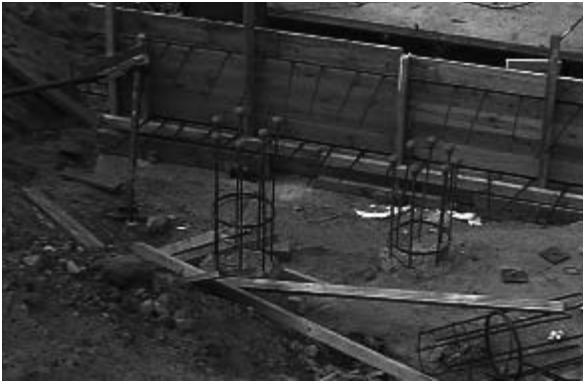
Un terreny amb baixa capacitat portant genera un encariment de la fonamentació.
