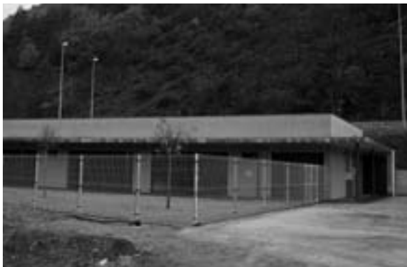
Vista de la tanca exterior del centre.
