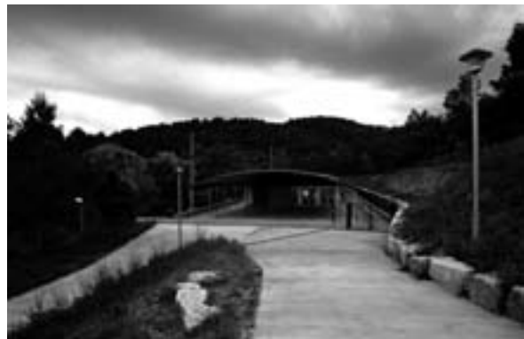
Un terreny amb pendent pronunciada obliga a terreplanar i genera nombrosos murs de contenció per tal d'obtenir una superfície plana.
