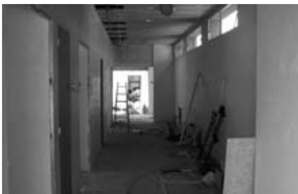
Un cel ras practicable facilita el manteniment.
