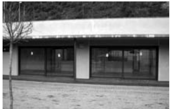
Vista del porxo de protecció exterior de les aules.
