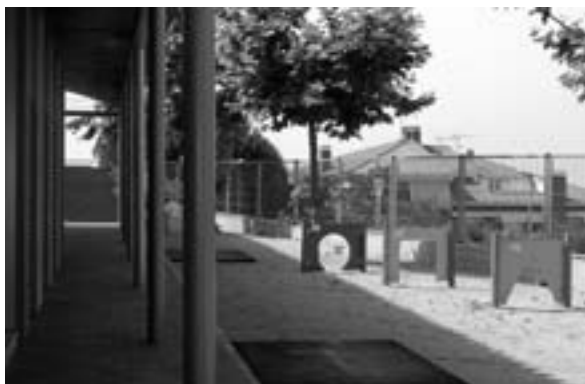
Vista de diversos paviments en la sortida a un pati.
