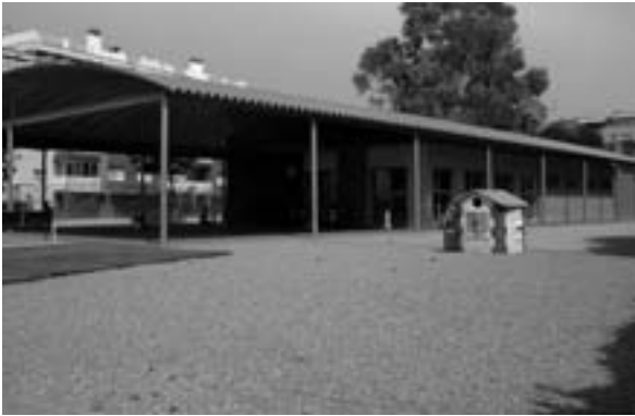
Vista de l'accés a l'edifici amb el porxo d'entrada.
