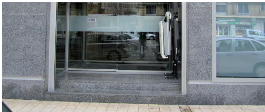
Imagen 143. Punto de entrada a un establecimiento con plataforma salvaescaleras.
