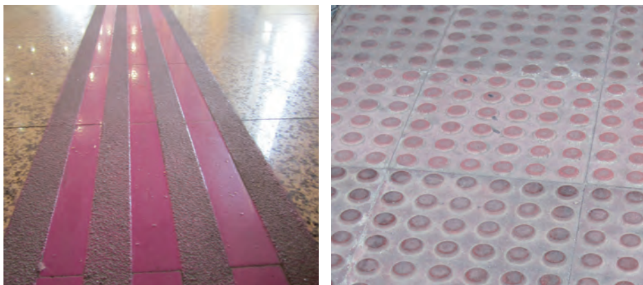
Imágenes 44 y 45. Imagen real de los dos tipos de pavimentos táctiles.
