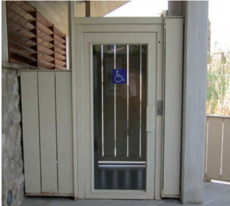
Imágenes 158 y 159. Puerta de ascensor transparente y franjas de encaminamiento hasta la misma.
