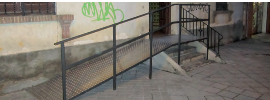
Imagen 142. Rampa de acceso a un edificio residencial.
