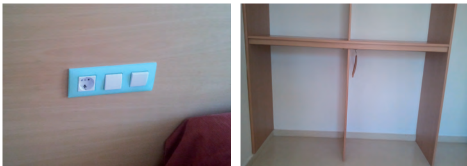
Imágenes 181 y 182. Enchufes e interruptores de la luz diferenciados cromáticamente del paramento y armario al mismo nivel del suelo.
