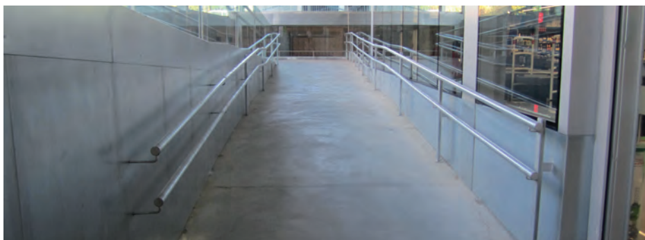
Imagen 88. Rampa accesible con pasamanos a ambos lados y a doble altura.
