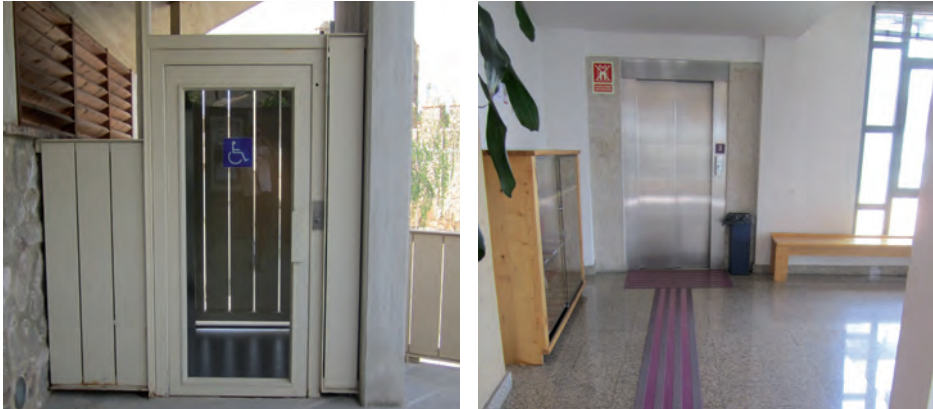
Imágenes 99 y 100. Puerta de ascensor transparente y franjas de encaminamiento hasta la misma.
