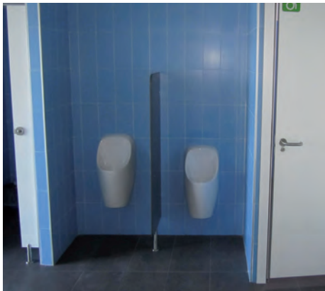
Imágenes 58 y 59. Detalle de colocación de urinarios a diferentes alturas.
