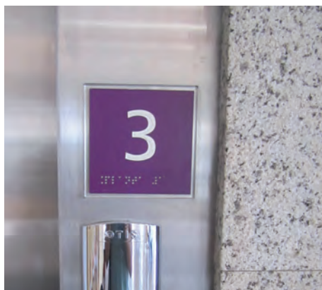
Imágenes 36 y 37. Detalle de la precisión de nivelación del ascensor, el espacio entre el suelo y la cabina y la botonera del ascensor en braille.
