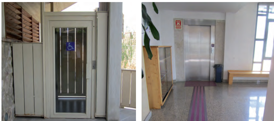
Imágenes 34 y 35. Puerta de ascensor transparente y franjas de encaminamiento hasta la misma
