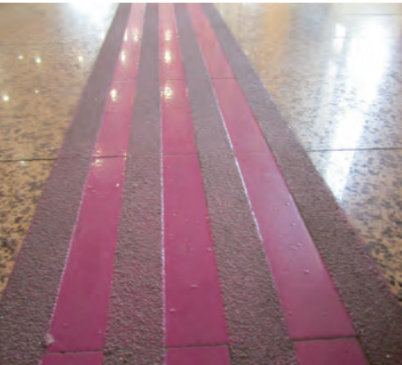
Imágenes 109 y 110. Imagen real de los dos tipos de pavimentos táctiles.
