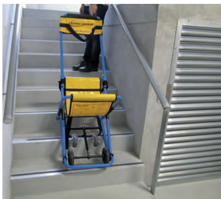
Imagen 202. Silla de evacuación de emergencia.
