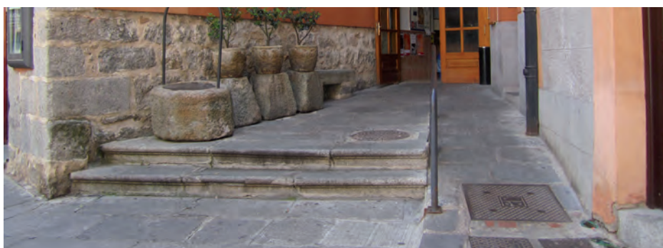
Imagen 77. Rampa de acceso a un restaurante.
