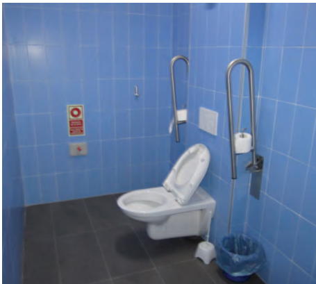
Imágenes 127, 128 y 129. Detalle de colocación barras de transferencia y sujeción.
