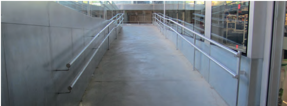
Imagen 25. Rampa accesible con pasamanos a ambos lados y a doble altura.
