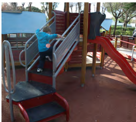
Imagen 6. Los toboganes cumplen con requisitos de accesibilidad, al contar con una escalera con barandillas, huella y tabica de dimensiones generosas, así como una zona de transferencia en el segundo escalón.
