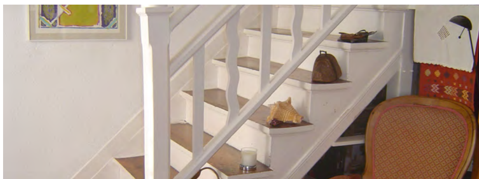
Imagen 74. Escalera con pendiente muy acusada. Casa unifamiliar antigua.
