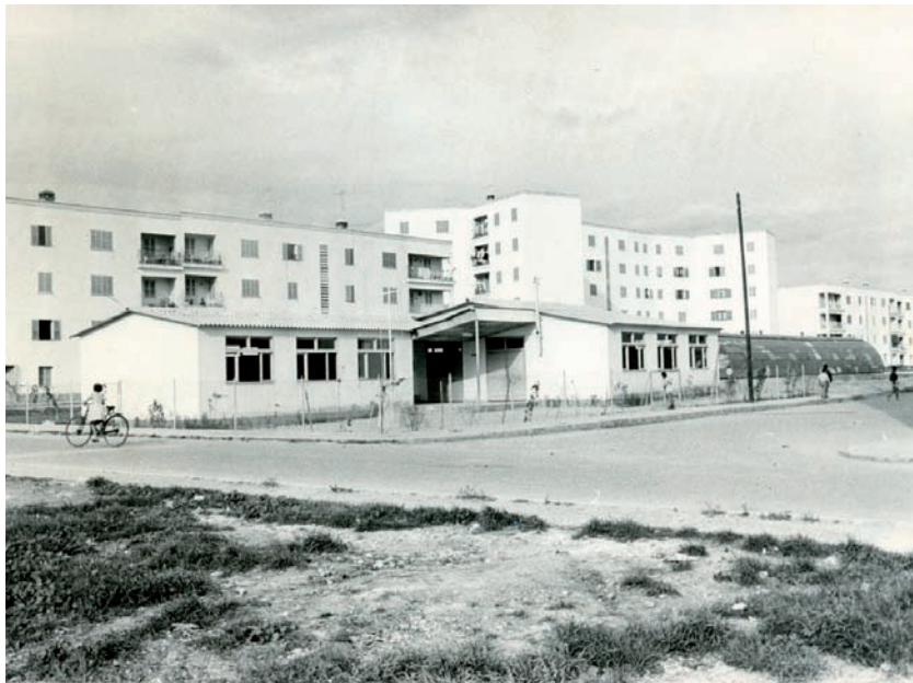
1962. Escoleta prefabricada instal·lada al grup de vivendes Verge de Lluc
