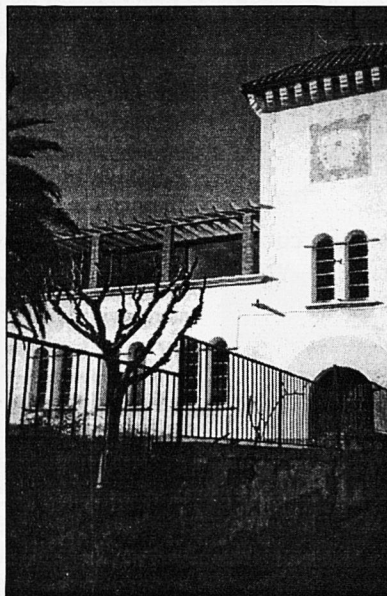
Escola de Palau. (Foto: Jordi Feu).
