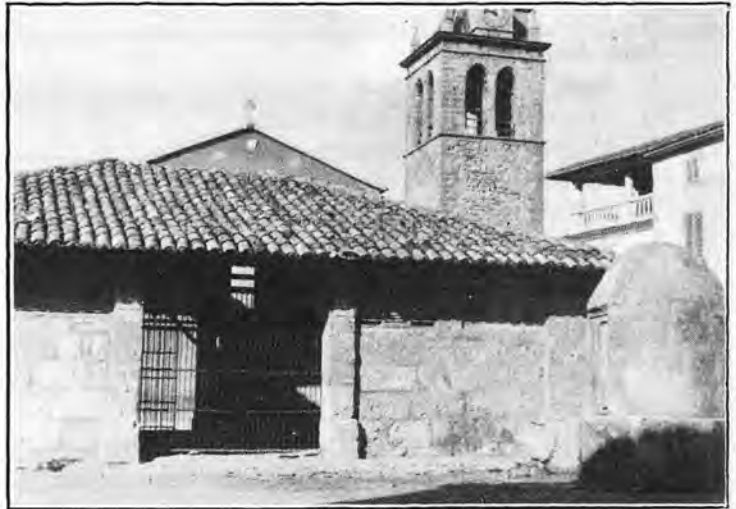
Vista de la plaza del mercado y pozo público de la misma poco antes de su demolición. Al fondo la iglesia parroquial del Santo Cristo.
