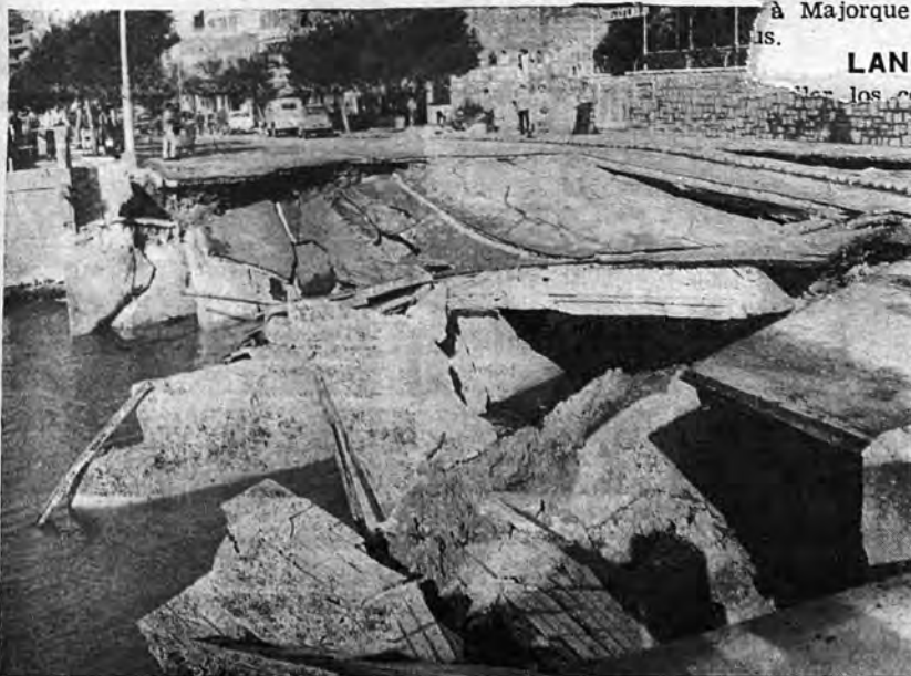
Cette photo de CASTELL, prise le 26 septembre au matin, nous montre dans l'état où est resté le Pont du Paseo Marítimo, près de l'Hôtel Bahia-Palace, après la furieuse avalanche qui s'est abattue sur la région de Palma.
