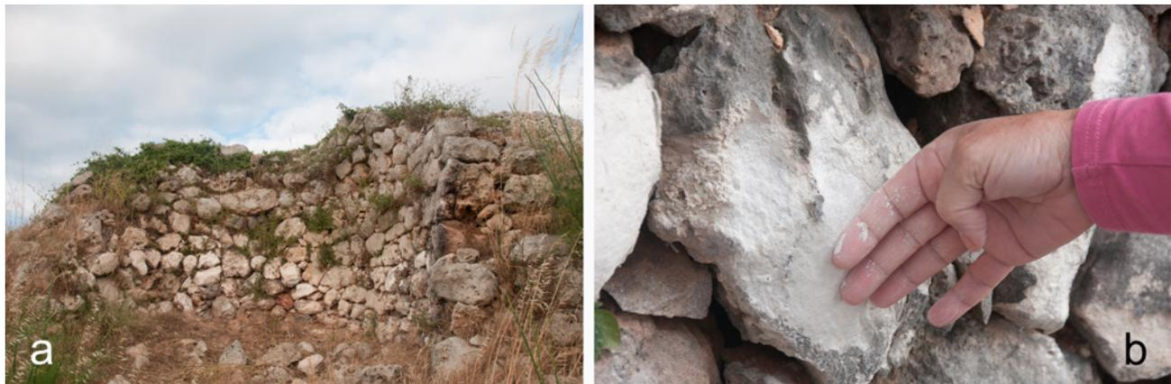
Figura 8: Horno de cal de Trebalúger (Menorca) (a) y un detalle de la cara interior del muro (b).
