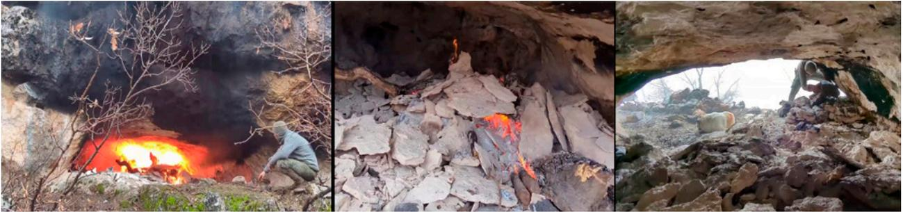
Figura 15: Fotogramas extraídos de un vídeo de un proceso de incendio de cavidad para su ampliación volumétrica donde puede observarse el laminamiento/exfoliación del techo y la curvatura resultante tan característica de la bóveda.
