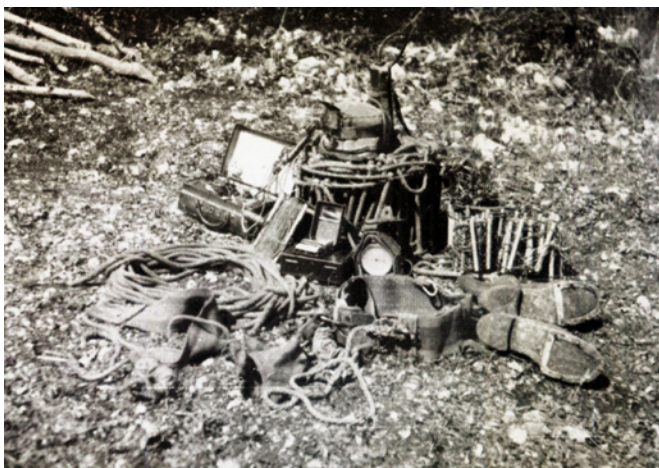
Figura 2: Entre les innovacions introduïdes per Robert de Joly en el material per a la pràctica espeleològica destaquen les escales lleugeres de cable d'acer, que apareixen enrodillades a la dreta de la fotografia (Font: JOLY, 1968).
