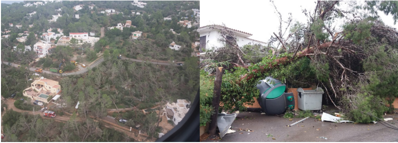
Figura 47. Els mitjans actuant en fase d'emergència a la urbanització de Can Germà (esquerra) i detall d'alguns dels danys (dreta).
