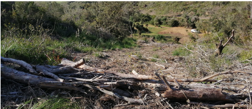
Figura 35. Feixines amb trituració manual del material forestal per a la prevenció de l'erosió per escorrentia.
