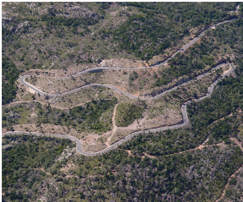
Figura 66. Fotografia aèria de la Ma-10 (punt quilomètric 76); s'hi aprecia clarament la faixa executada.
