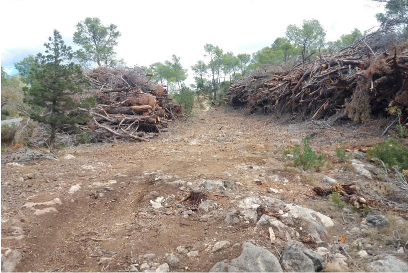
Figura 51. Troncs apilats a zona executada de la faixa del Pla Comarcal a la finca Can Bernat.
