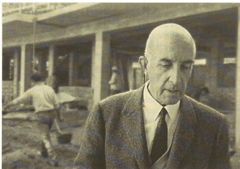
Revisant les obres de l'Auditorium cap a 1968 (col·lecció família Ferragut, gentilesa de Bernardo Obrador)
