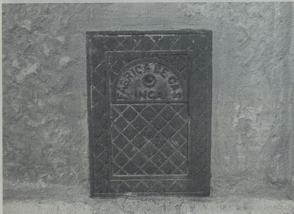
Porteta de connexió del gas a una casa particular (domicili de Domingo Alzina i Jaume, de la plaça de l'Orgue).
