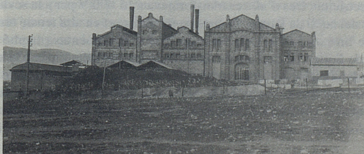
Central elèctrica de la Societat d'Enllumenat per Gas de Palma (1922). Fotografia: fons històric de Gesa Endesa.
