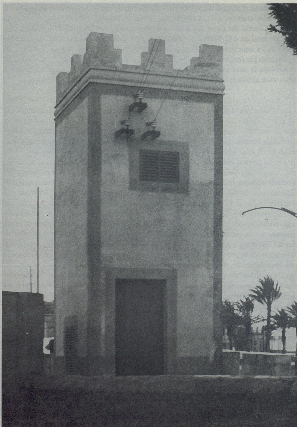
Edifici d'una estació transformadora de 1929. Fons històric de Gesa Endesa.
