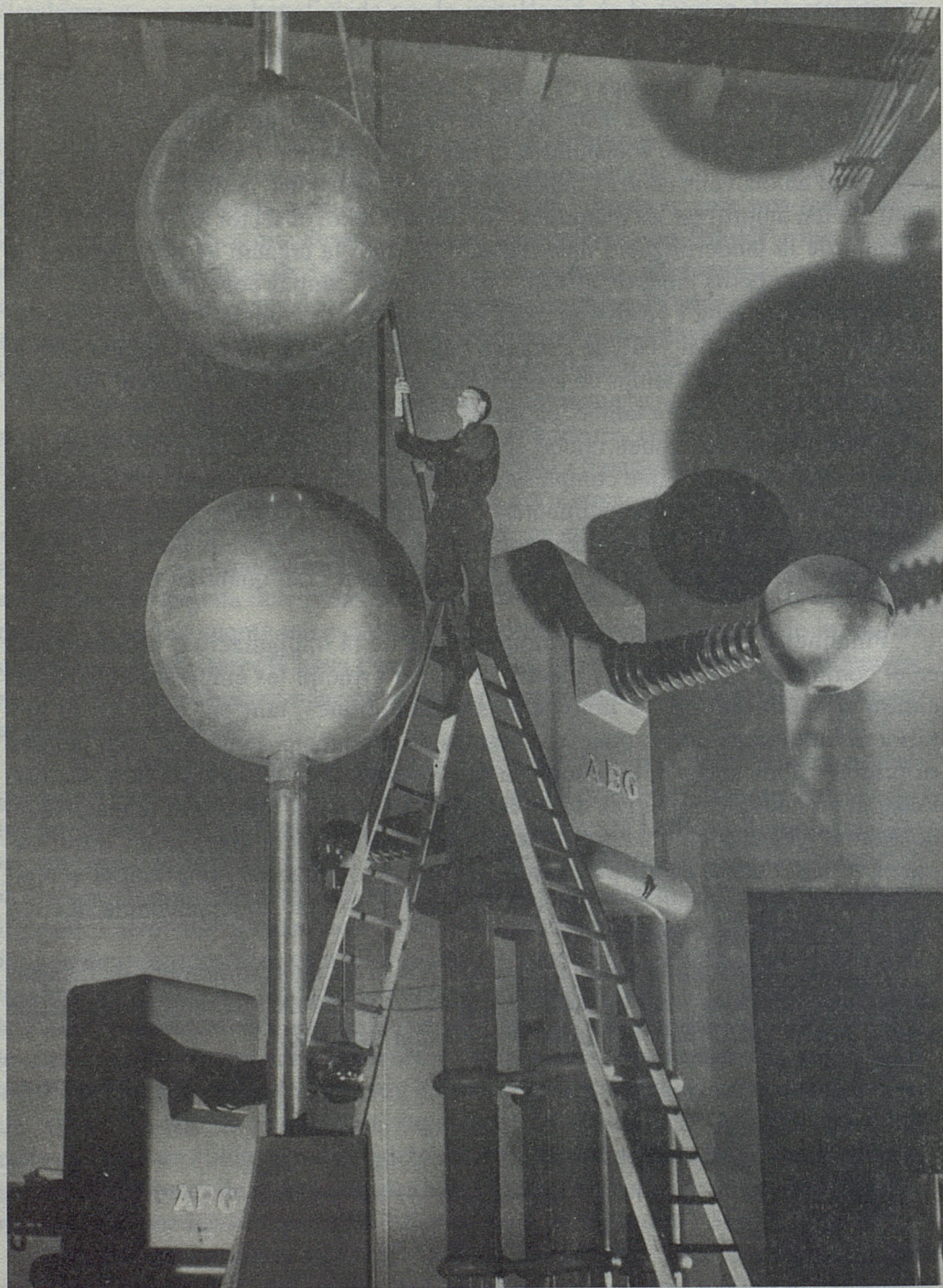
La investigació a la indústria elèctrica era fonamental. Laboratori de transformadors de AEG a Berlín. 1953.
