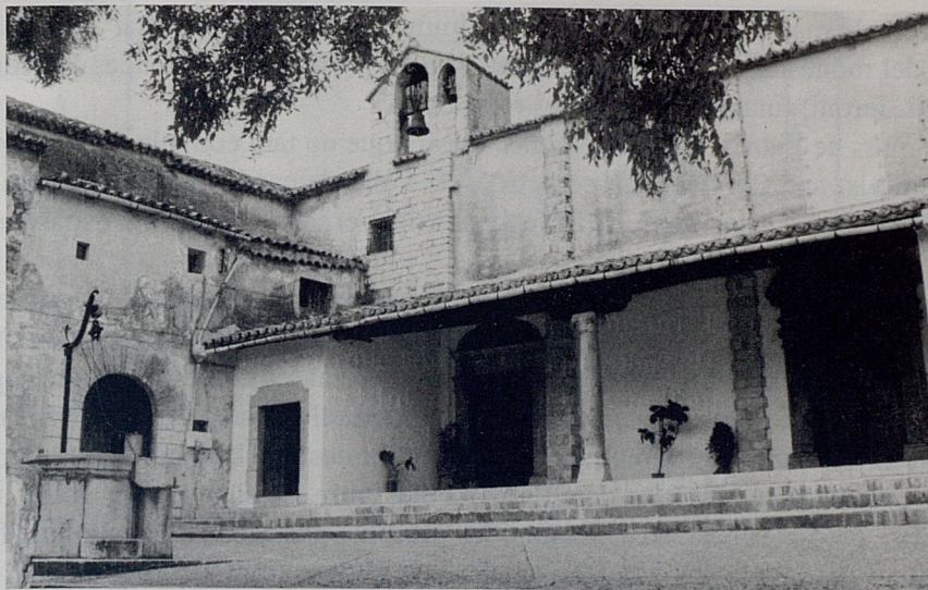
Façana de St. Bartomeu d'Inca. (Convent de les Monges Jerònimes).
