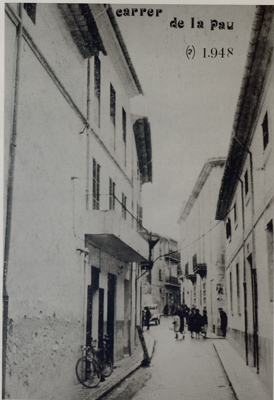
— Antic "Carrer de La Pau". A la dreta, "Plaça del Sol". Actual "Miquel Duran".
