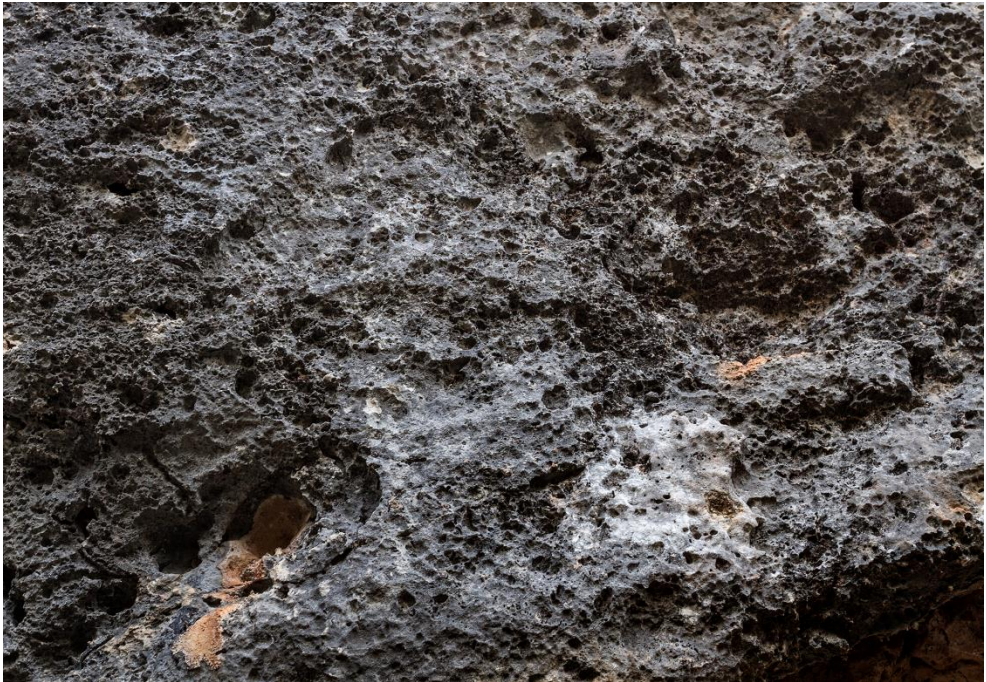
Fig. 16. Alvèols amb una morfologia de pouet ( Rainpit ), però amb una secció individual horitzontal i a sobre una superfície vertical, el que fa pensar amb l'aigua que s'adhereix a la roca com la seva possible gènesi ( Cavernous weathering ). L'amplada de la vista és de 1,5 m.
