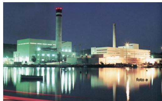
Fig. 8. Central tèrmica de GESA a Maó (1993).
