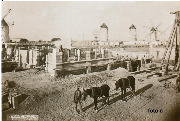
Fig. 5. Imatge amb quatre molins fariners i un altre d'extracció d'aigua, muntat sobre un castellet, avui desapareguts, la màquina de la dreta clavant pilons mitjançant tracció animal.
