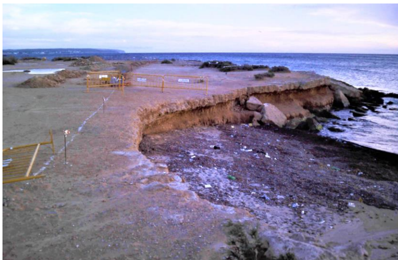
Fig. 11. Es pot observar per on havia de passar el passeig. La síquia arribava fins les barreres. Després es varen aturar les obres en aquest indret i es va rectificar el traçat en tot el tram de cala Pudent. Foto feta de cala Pudent cap on es va fer la foto de la Fig. 9 (Foto D. Vicens).
