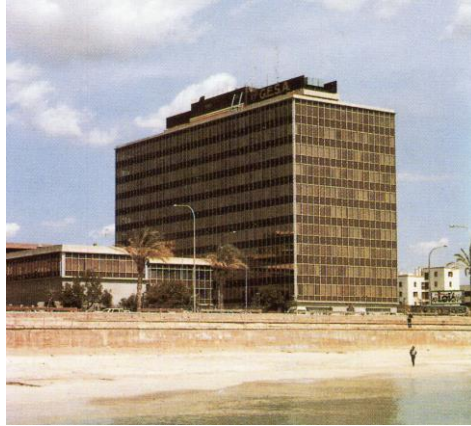
Fig. 3. Edifici GESA, inaugurat el 1978, obra de l'arquitecte José Ferragut Pou (1912-1968).
