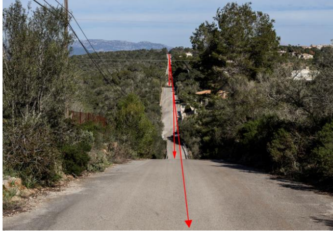
Fig. 24. A la fotografia s'aprecia la important incisió dels canals de drenatge de la part superior de la plataforma analitzada, en primer pla el Comellar Fondo. No obstant, aquests canals tenen una carència d'una conca hídrica de recepció que pugui justificar el seu desenvolupament.
