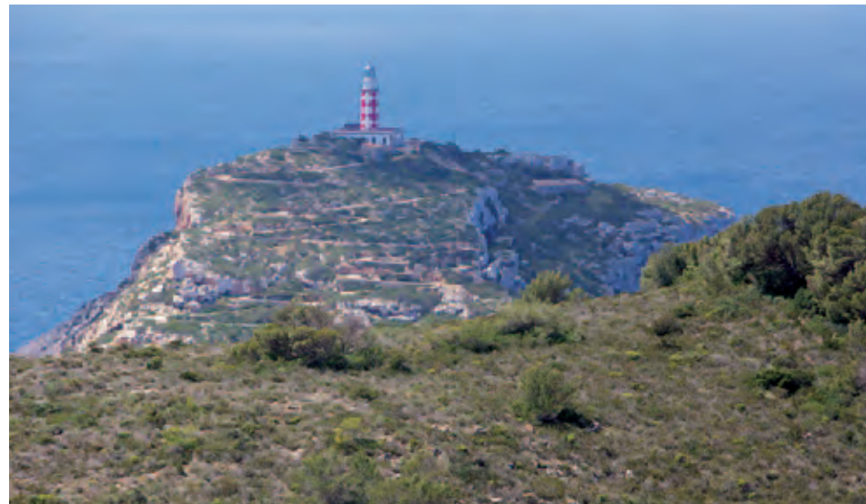
El far de n'Enciola, al migjorn de Cabrera, amb la pista d'accés i les runes dels barracons on habitaren els obrers que feren l'obra a la segona meitat del segle XIX. Aquestes actuacions, tot i que suposen una alteració evident del paisatge natural, no resultaven agressives, ja que la tecnologia i la sensibilitat dels tècnics que les projectaren i dirigiren proposaven l'ús de materials locals, obres de pedra en sec i poques alteracions del relleu. Avui són paisatges patrimonials de gran valor. (Foto: Louis-Marie Préau, Conservatoire du littoral/PIM)
