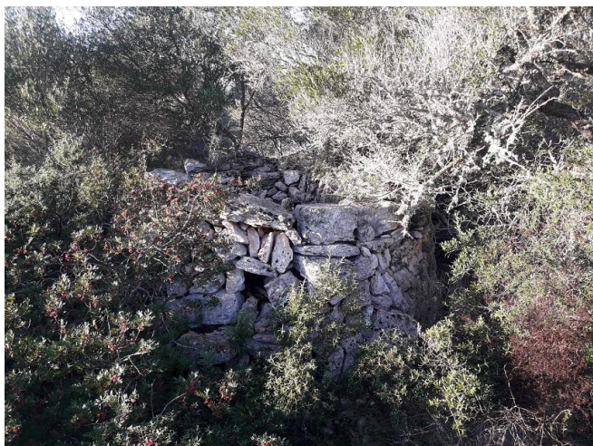
Fig. 5. Barraca de pedra en sec per a la caça de la perdiu amb reclam. Foto. Sebastià Ferragut
