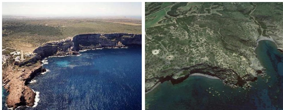
Figura 8. A la izquierda acantilado vertical sobre Mioceno de son Morell Nou. La zona boscosa situa al fondo a la izquierda, corresponde a al ubicación del manto eólico. Vista hacia el SW. Fuente: MAGRANA. Vista oblicua hacia el Sur del acantilado de sa Marina de s'Arena sobre Carbonífero. En el centro se puede apreciar el tono más claro del manto. Fuente: Google Earth.
