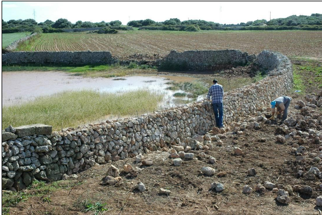
Fig. 6. Restauració de parets seques a la bassa de Torrellafuda
