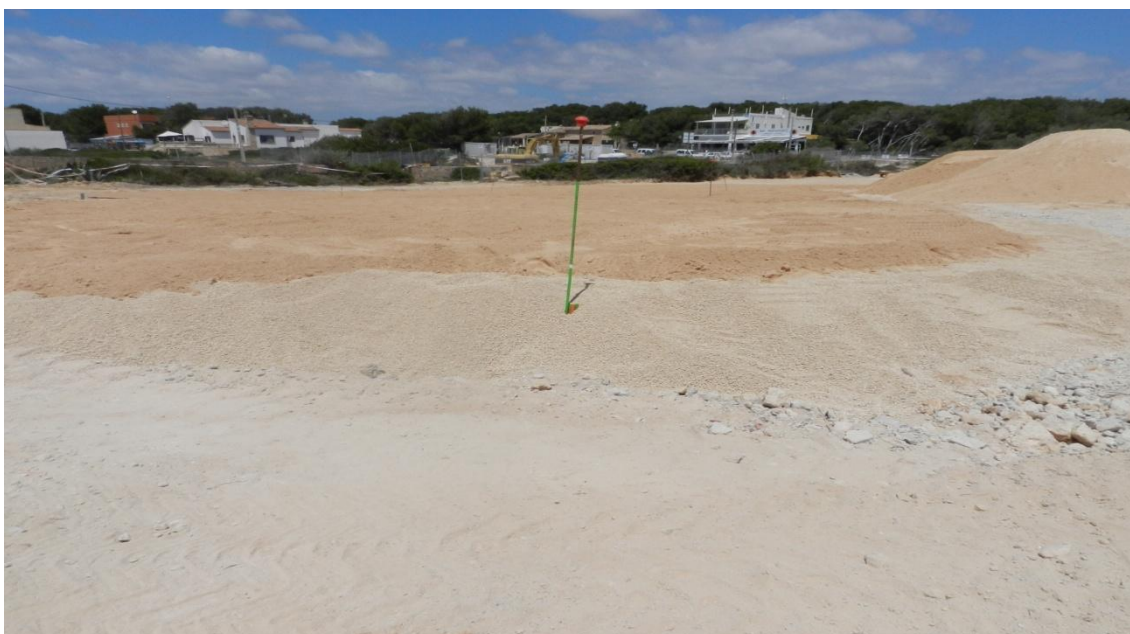
Fig. 18. Restauració edàfica d'acord amb els perfils i característiques texturals determinades en projecte.
