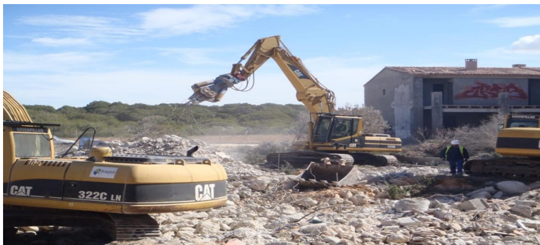
Fig. 8. Treballs fragmentació i separació selectiva RCD
