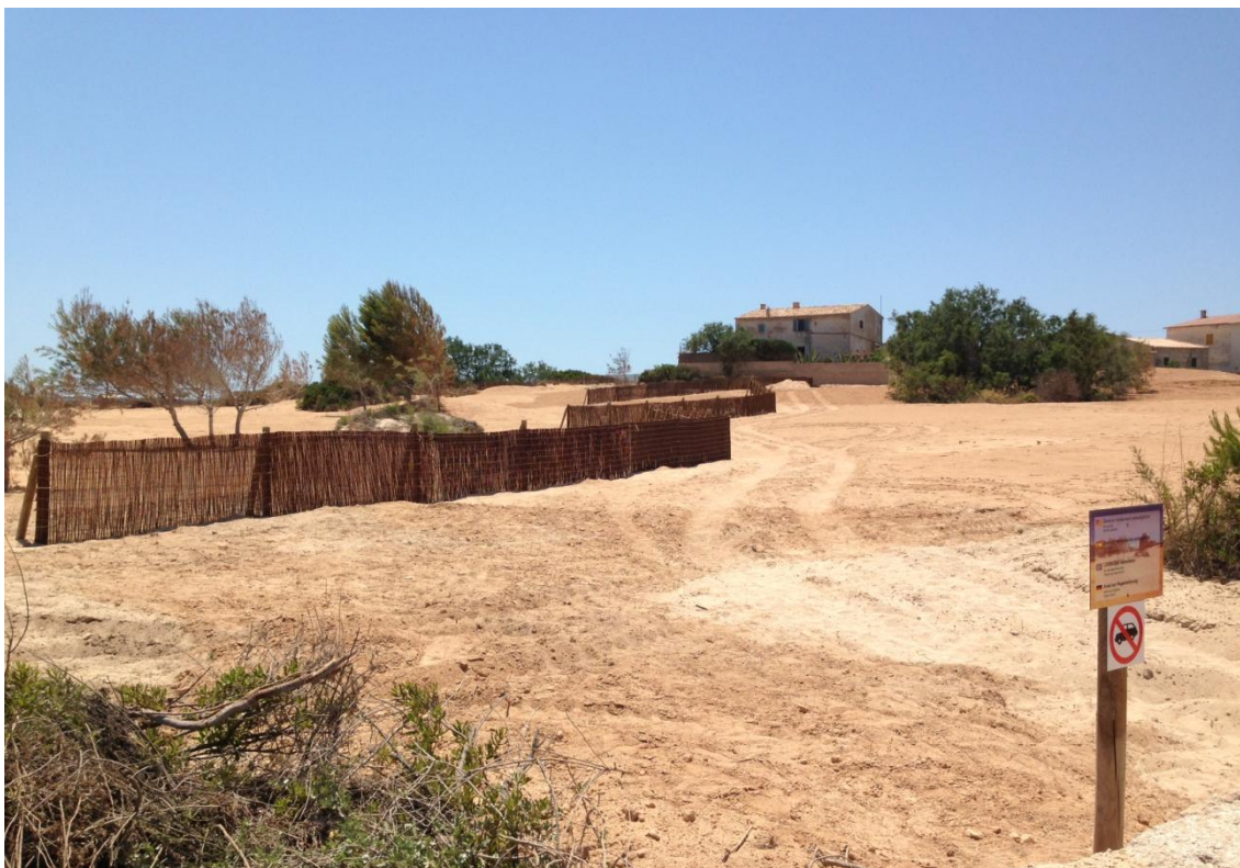
Fig. 22. Instal·lació captadors d'arena
