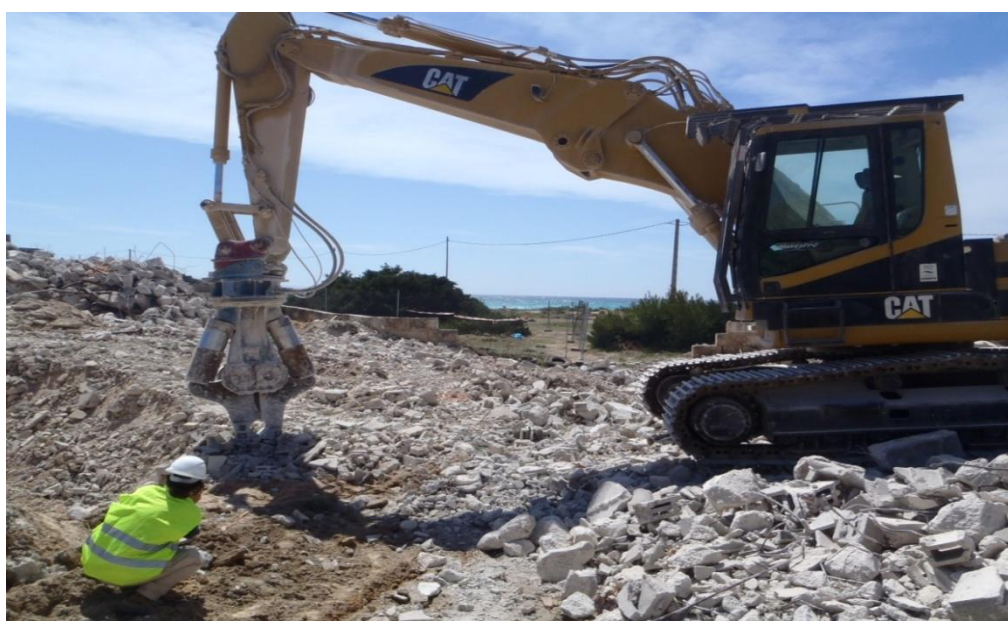
Fig. 8. Treballs fragmentació i separació selectiva RCD
