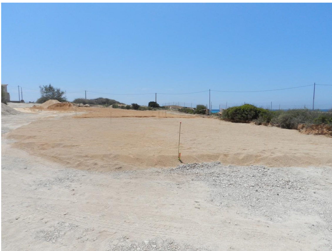
Fig. 17. Disposició dels tres tipus de materials utilitzats per la restitució del perfils topogràfics i edàfics
