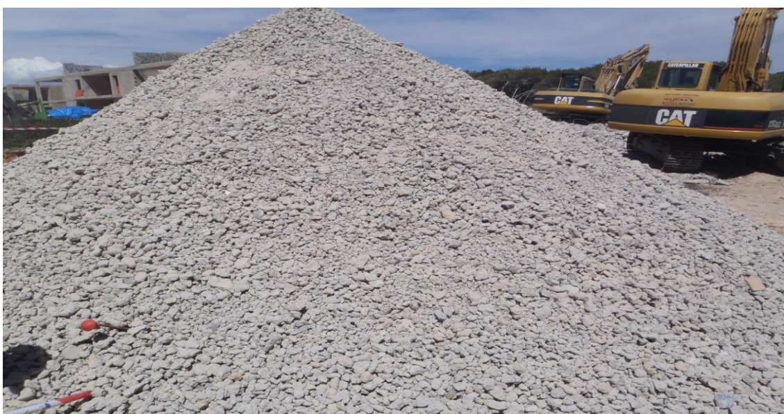
Fig. 14. Dipòsit temporal residus construcció i demolició, fracció formigó Codi LER 17 01 01 abans de la seva valorització "in situ" mitjançant rebliment de zones excavades de la demolició
