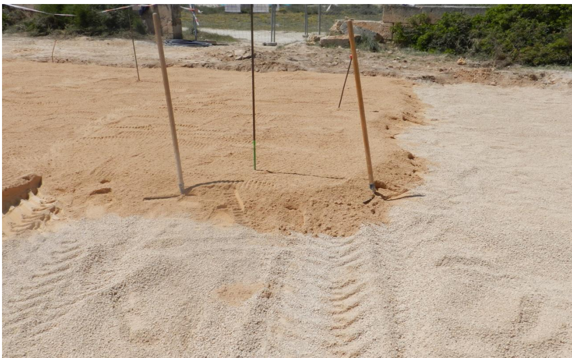
Fig. 21. Restitució sòl part inferior grava fines de picadís "pinyol" i arena a la part superior.
