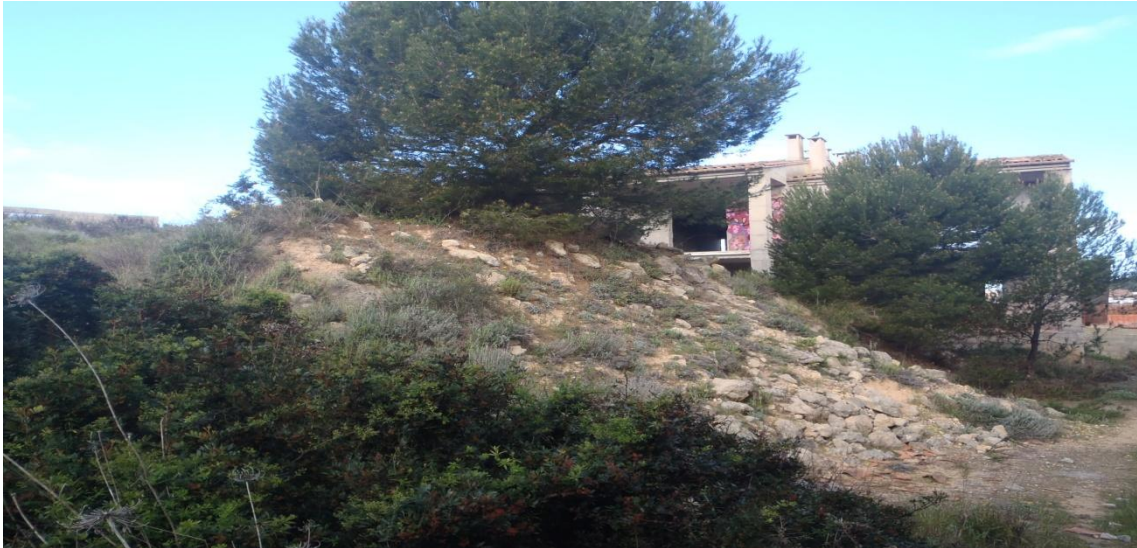
Fig. 6. Amuntegament interior material terrigen provinent de l'excavació durant la construcció dels edificis.
