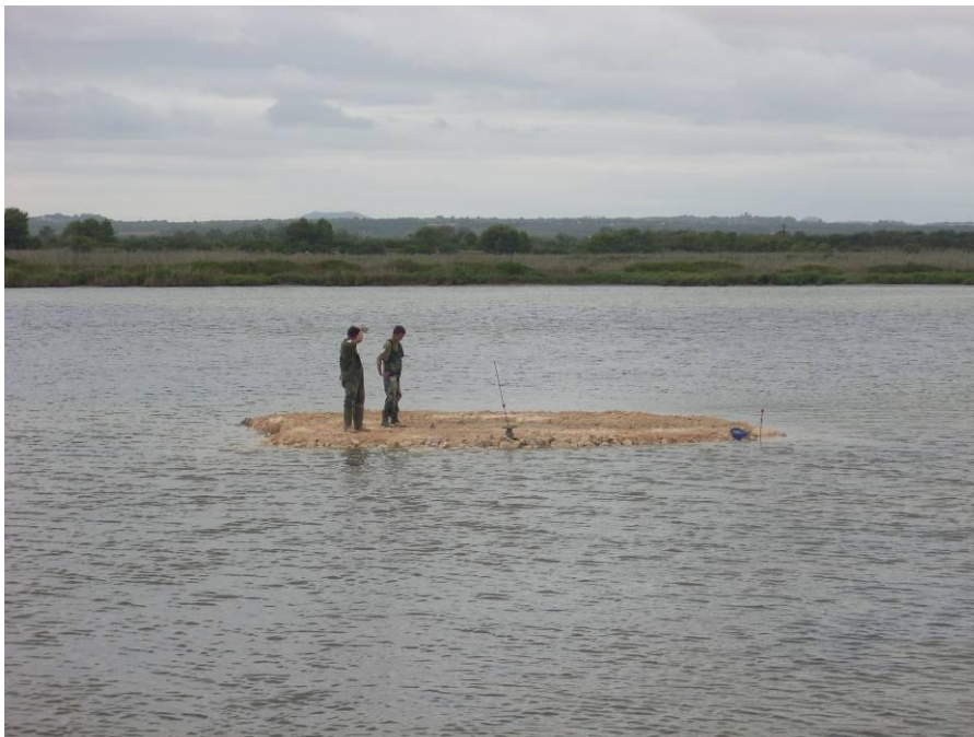
Foto 2. Construcció d'una illota de 40 metres quadrats, amb marès, grava i restes d'organismes trobats a la zona, com ara copinyes.
