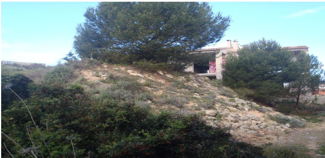
Fig. 6. Amuntegament interior material terrigen provinent de l'excavació durant la construcció dels edificis.
