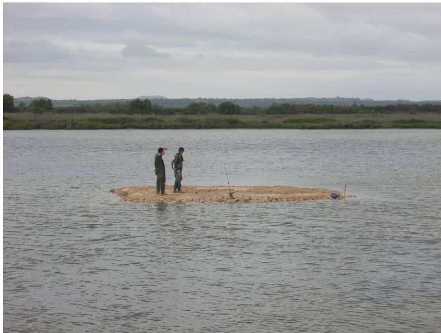
Foto 2. Construcció d'una illota de 40 metres quadrats, amb marès, grava i restes d'organismes trobats a la zona, com ara copinyes.
