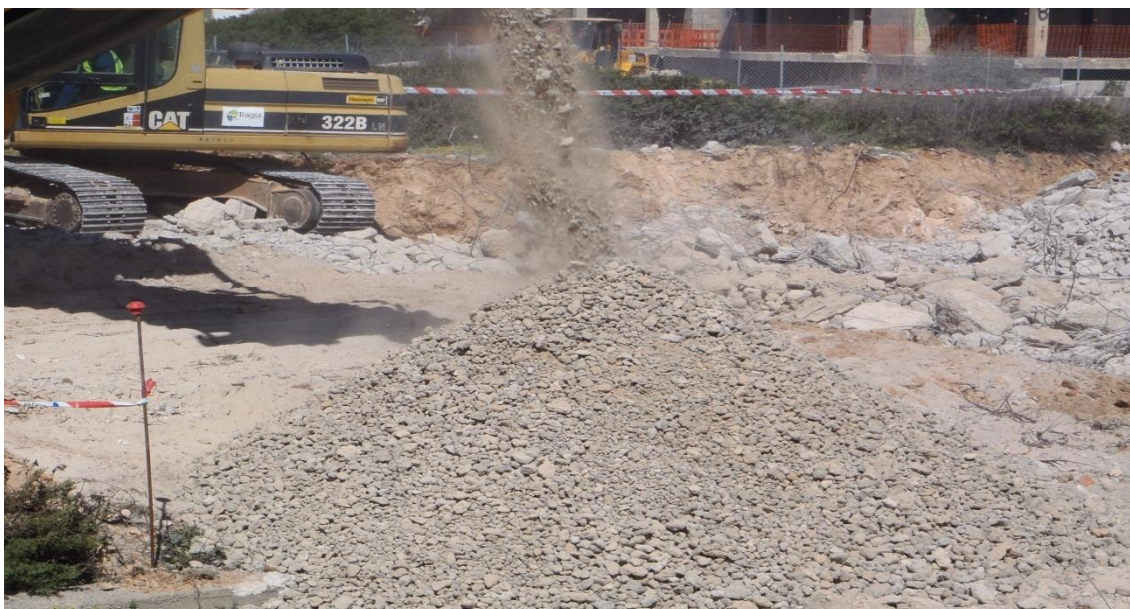
Fig. 12. Fragmentació i dipòsit temporal de residus construcció i demolició, fracció formigó Codi LER 17 01 01.
