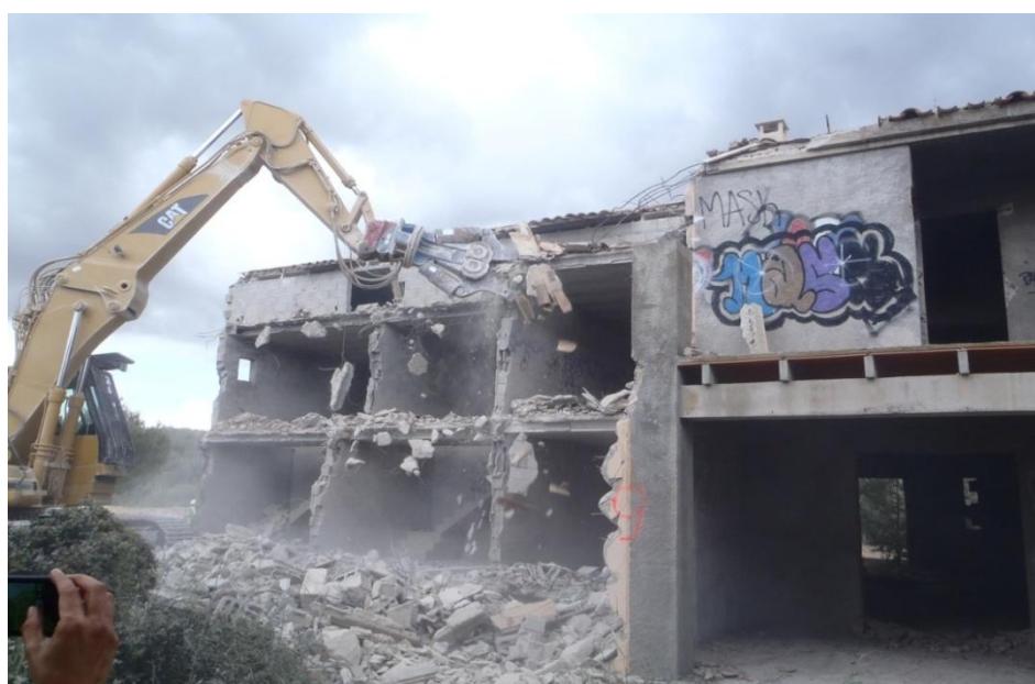
Fig. 9 i 10. Demolició selectiva, detall fragmentació material fèrric i formigó
