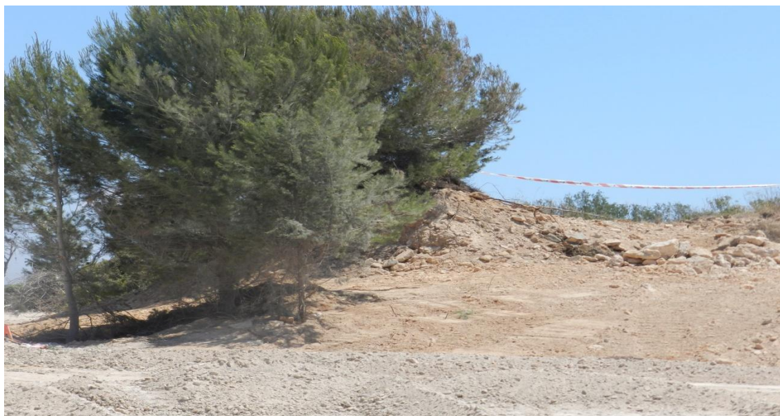
Fig. 16. Terraplenament materials capa inferior de restitució perfil topogràfic.
