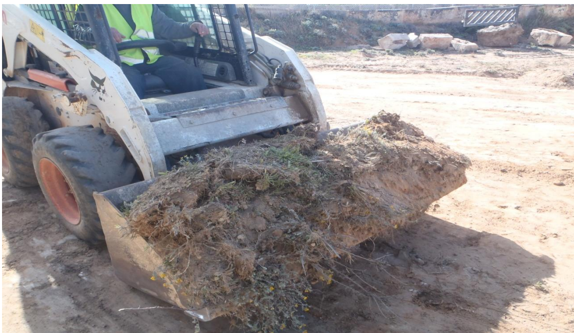
Fig. 4. Decapatge horitzó superficial de zones no construïdes
