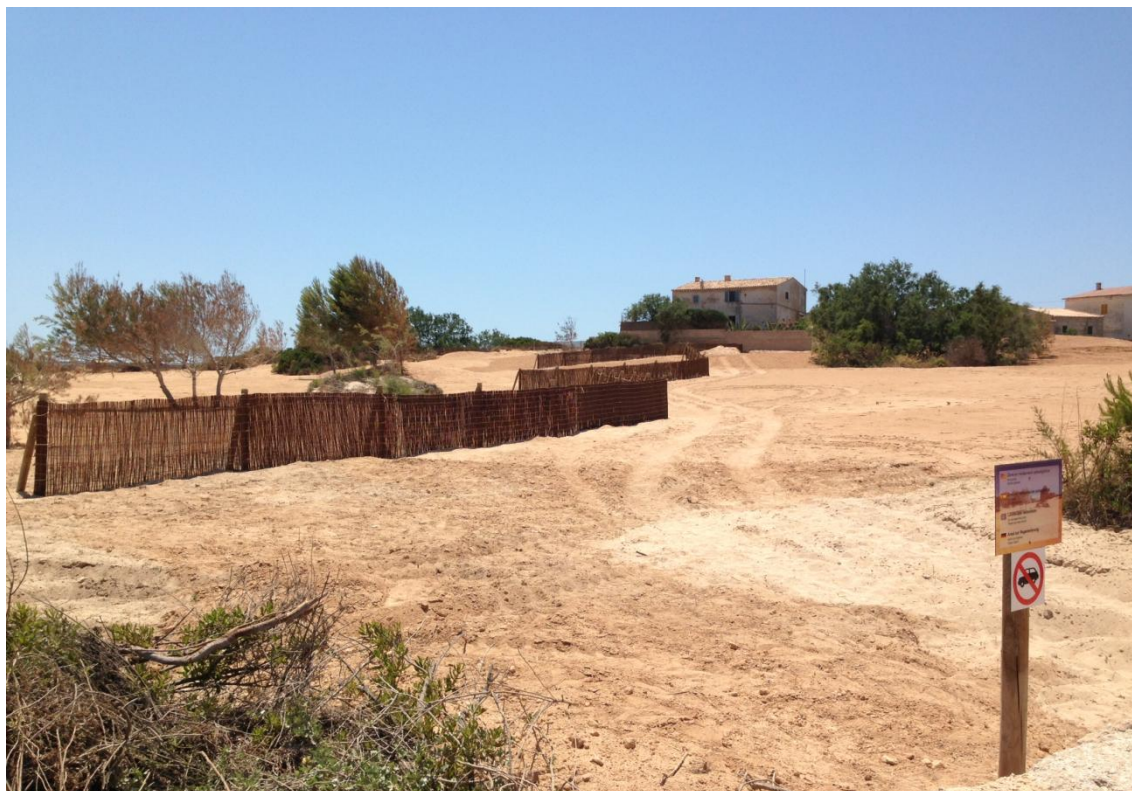
Fig. 22. Instal·lació captadors d'arena
