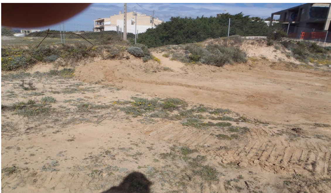
Fig. 5. Decapatge de l'horitzó superficial en zones no construïdes en la zona d'actuació.
