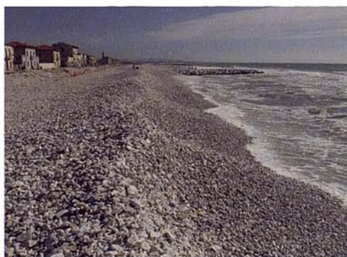
Fig. 10. Playa de gravas en la parte sur de Marina di Pisa donde se ha rebajado el rompeolas externo.
