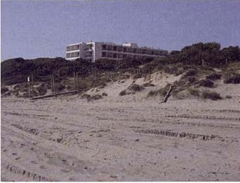
Fig. 4. Modificación del perfil de playa y alteración del pie de duna con la limpieza mecánica. Sant Tomàs, año 2000 (Menorca).
