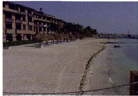
Fig. 6. Después de la ejecución del proyecto de playa en el Blue Bay Club, Cancún, México.
