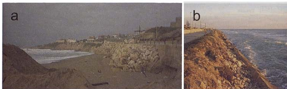
Fig. 4. Erosión aguas abajo del Puerto de Scoglitti (a), bloques de protección de la carretera litoral en Santa María del Focallo (b).
