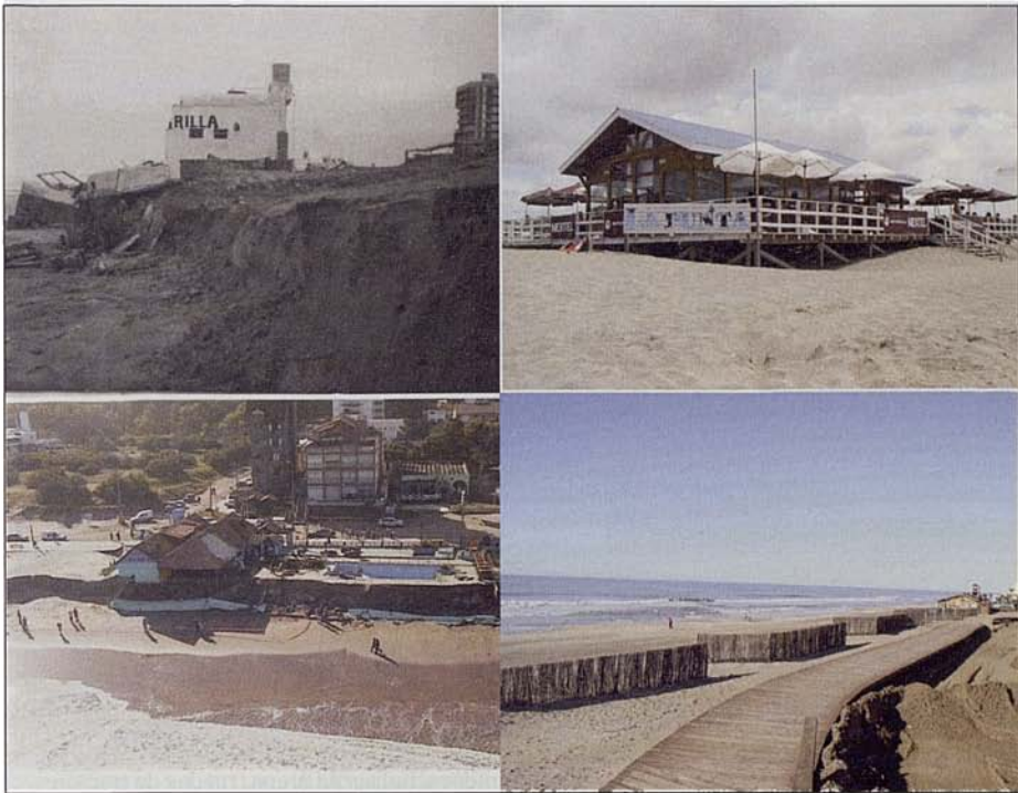
Fig. 6. Algunas construcciones balnearias y avenidas costaneras fueron sucumbiendo irremediablemente a la erosión episódica (izquierda). Las alternativas fueron los balnearios construidos en madera, y reemplazar avenidas costaneras con paseos pedestres con cercas (derecha). Fig. 6. Some constructions and coastal avenues fell down to episodic waves (left). The alternatives were wood-constructed seaside resorts and to replace avenues with walkways with fences (right).
