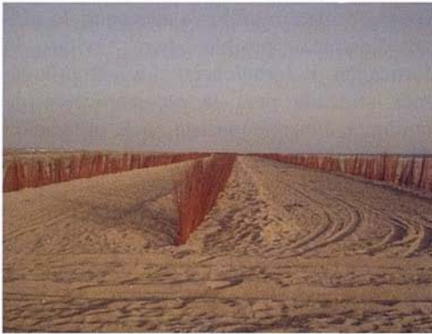
Fig. 2. Captadores de arena de mimbre. Fig. 2. Sand wicker collectors.
