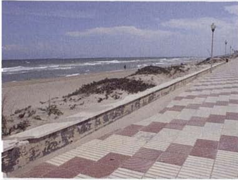
Fig. 13. Aspecto de la zona de estudio antes de la actuación.
