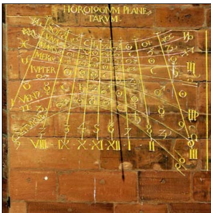
Figura 7: Rellotge planetari, en el qual es poden veure els signes del planetes que governen cada hora, no de tot l'any perquè seria gairebé impossible incloure-les, però sí per cada dia de canvi de signe zodiacal representat per aquestes corbes hipèrboles que serveixen per dos signes exceptuant els dos més extrems dels solsticis que són úniques per ells.
