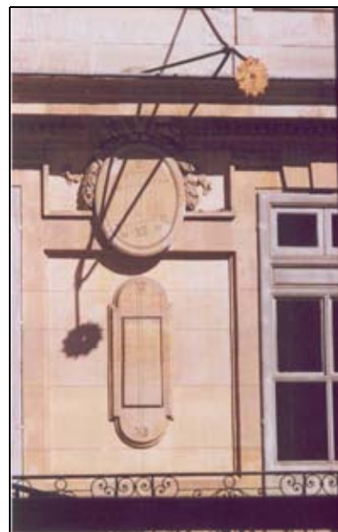
Figura 18: Una meridiana amb línies de calendari, al palau de Versalles, on es pot observar que el gnòmon és una plaqueta metàl·lica amb un petit forat que deixa passar un punt de llum per indicar l'hora amb una precisió molt millor.
