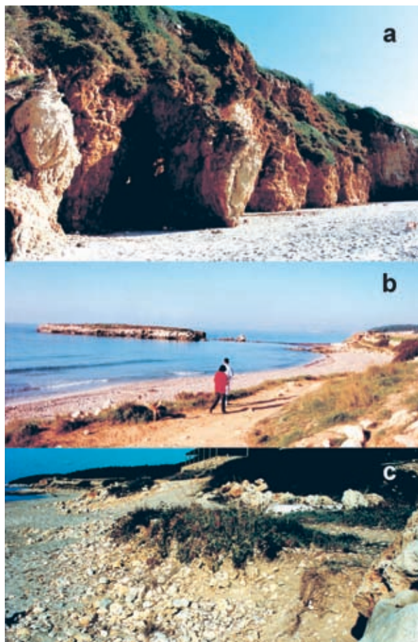
Fig. 11.9. a) Penya-segat i platja de Binigaus. Hom hi pot veure la inestabilitat del talús amb moviments de massa recents i, fins i tot, fragments acabats de desprendre, sobre l'arena (3.11.1996); b) Escull o illa de Biniquadrell, residu de l'avançada litoral que segueix cap a Atàlitx; c) Vora marina de Sant Tomàs-Biniquadrell. Restes de terrassa flandriana: còdols rodats i sòl negre incipient (3.11.1996).
