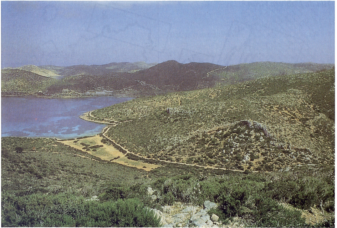
Fig. 10. Esllavissaments rocosos al vessant dret del Canal Llarg. A la desembocadura del torrent es poden veure dipòsits al·luvials utilitzats pel conreu.
