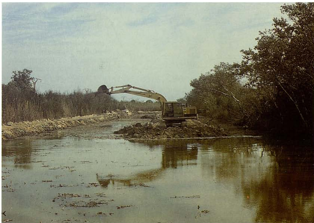
Dragat del Canal Gran Dredging at the Great Canal (Foto: Joan Mayol)
