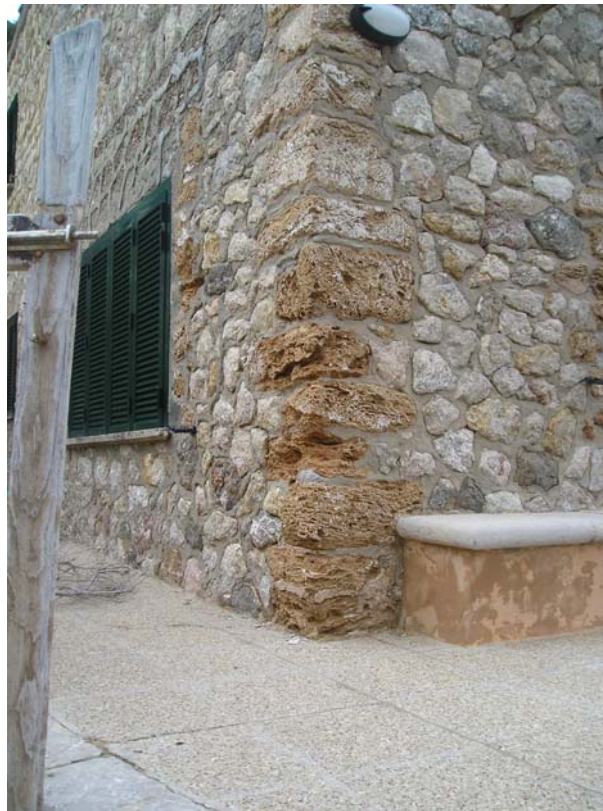
Fig. 3-12. Casa a cala Estellencs on s'han utilitzat tobès dels voltants com a material de construcció.
