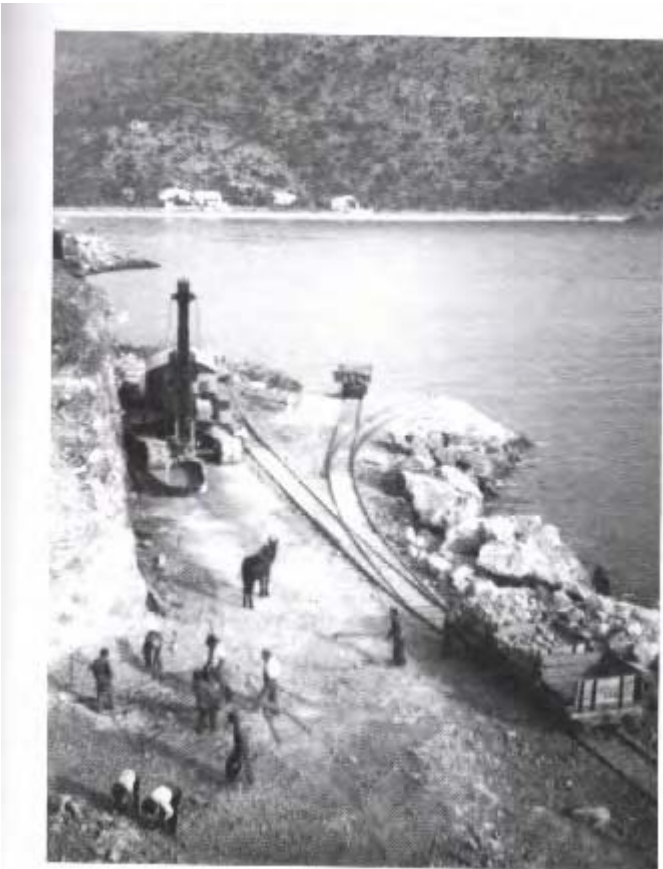
Imatge de la pedrera de les obres d'ampliació del moll comercial del Port, situada devora el far de sa Creu (font: SOLER, Rafel, Crònica dels Ports Balears , Palma, Documenta Balear, 2004).
