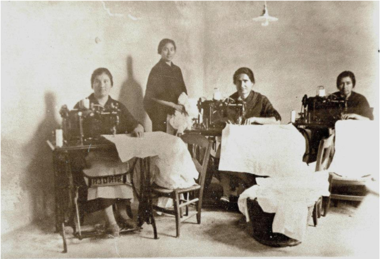
El Taller gran al carrer Pou. Primera meitat del s. XX. La dona asseguda de l'esquerra és Margalida Llinàs i la que està asseguda al centre Bàrbara Bauçà Morei (Arxiu Fotogràfic de l'Ajuntament de Sant Llorenç des Cardassar).
