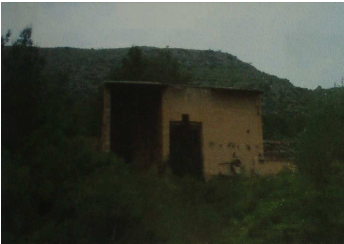
Fotografía 4: Mina de Son Fe. Imagen del Almacén.
