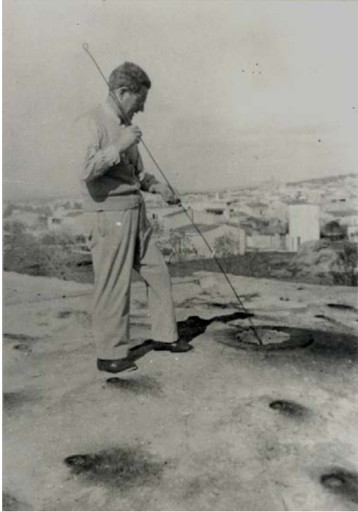
Fig. 8. Operari comprovant a través de la lluna l'estat de cocció de les peces. Imatge extreta d'ESTALL POLES, V., La industria cerámica en Onda. Las fábricas. 1778-1997 , Ajuntament d'Onda, Onda, 1997. Fig. 9. Forner tirant llenya al dau. Imatge extreta d'ESTALL POLES, V., La industria cerámica en Onda. Las fábricas. 1778-1997 , Ajuntament d'Onda, Onda, 1997.
