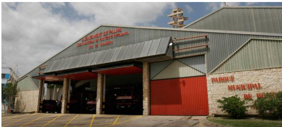
Fig. 3. Antigo Parque de Bomberos en Son Castelló. Vista parcial
