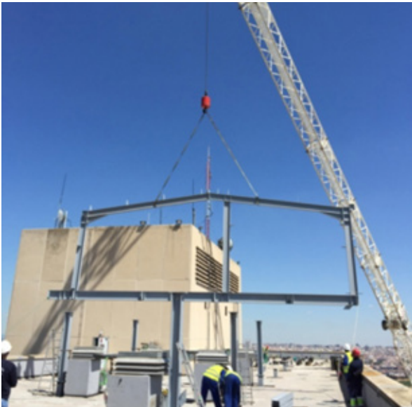
Figura 1: Montaje de la planta 24
