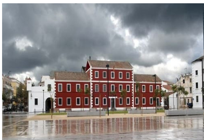
Figura 2. Estado actual del edificio que albergaba el Hospital Militar de Maó, en Es Castell.
