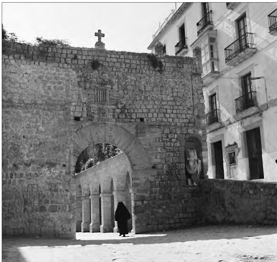
Figura 2. Entrada al cuerpo de guardia por el interior de la ciudad, verano de 1962. La estatua del togado es aún la auténtica, nótese que la casa adosada, mencionada por Piferrer y Quadrado, ya ha sido demolida (Fuente: J. M. Pando Barrero, IPCE, Fototeca del Patrimonio Histórico).
