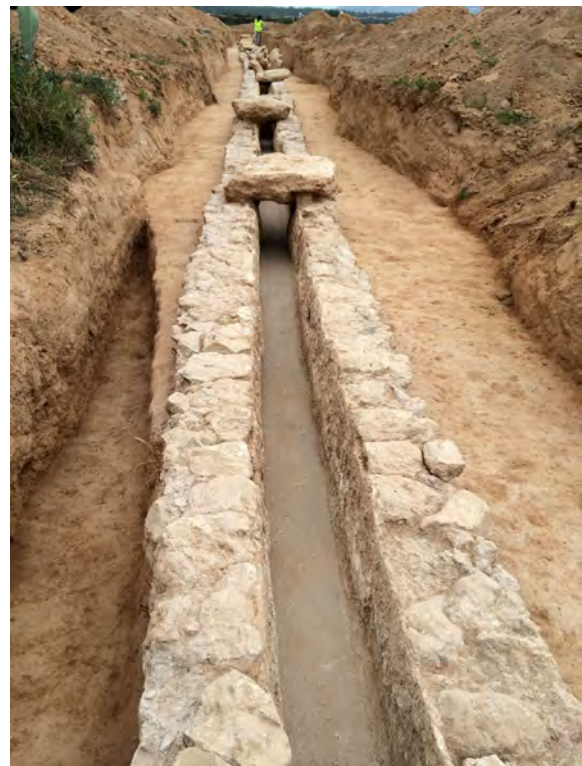
Figura 2. Vista del tramo excavado en Ses Estaques. (Fuente: ATICS S.L.)
