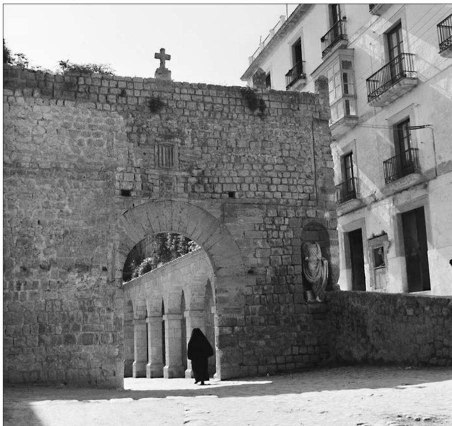
Figura 2. Entrada al cuerpo de guardia por el interior de la ciudad, verano de 1962. La estatua del togado es aún la auténtica, nótese que la casa adosada, mencionada por Piferrier y Quadrado, ya ha sido demolida (Fuente: J. M. Pando Barrero, IPCE, Fototeca del Patrimonio Histórico).
