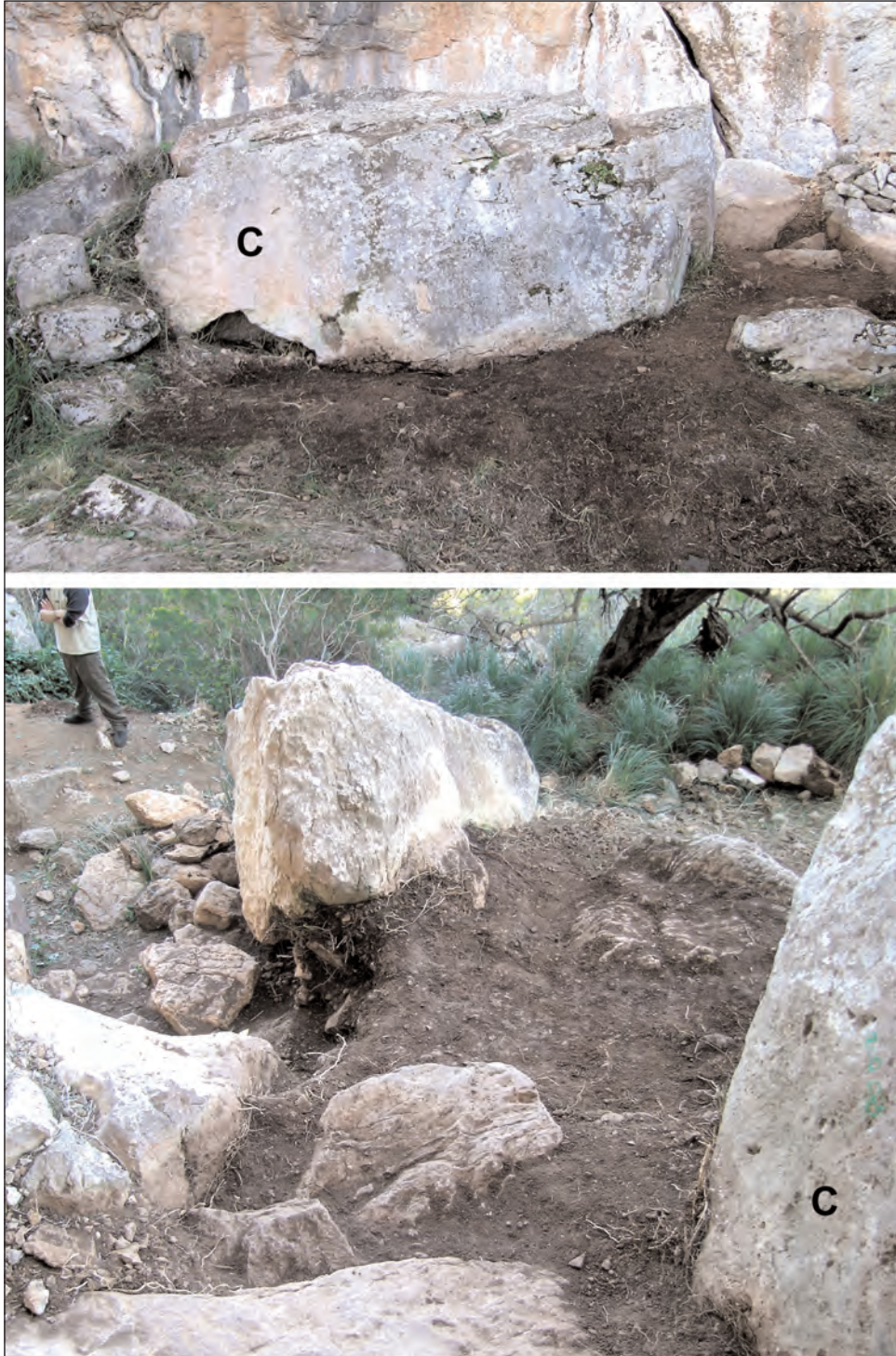
Fig. 10. Zona externa de los grandes desprendimientos.
