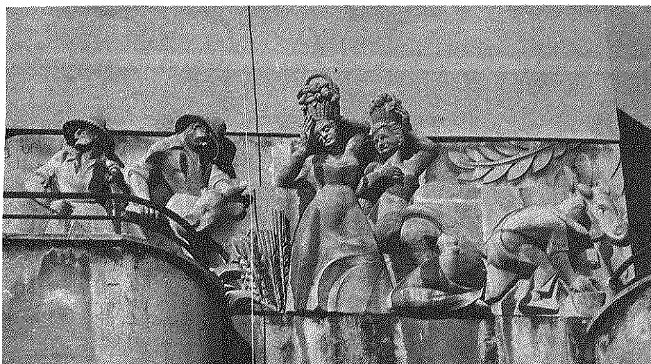
Lám. XI. Casa de Bernardo Salvá. Relieves de la fachada.
