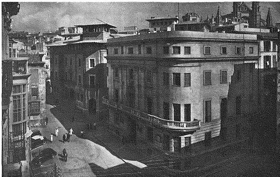
Lám. VIII. Edificio del Gobierno Civil. 1936-1940.
