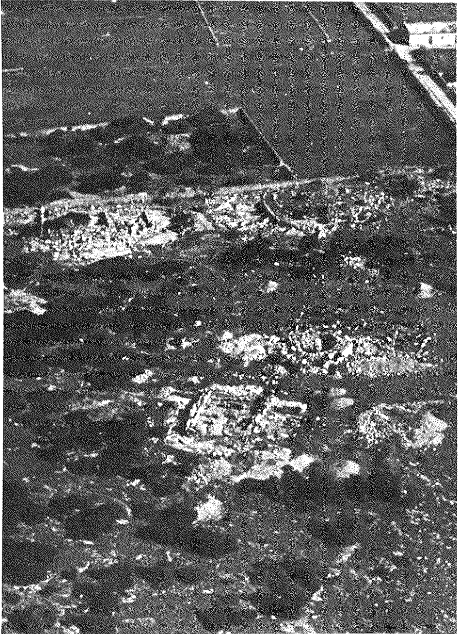
Lámina II: Vista aérea del conjunto de Son Oms en vías de excavación. En primer término el Santuario; al fondo el laberinto y túmulo escalonado antes de descubrir la sala hipóstila.
