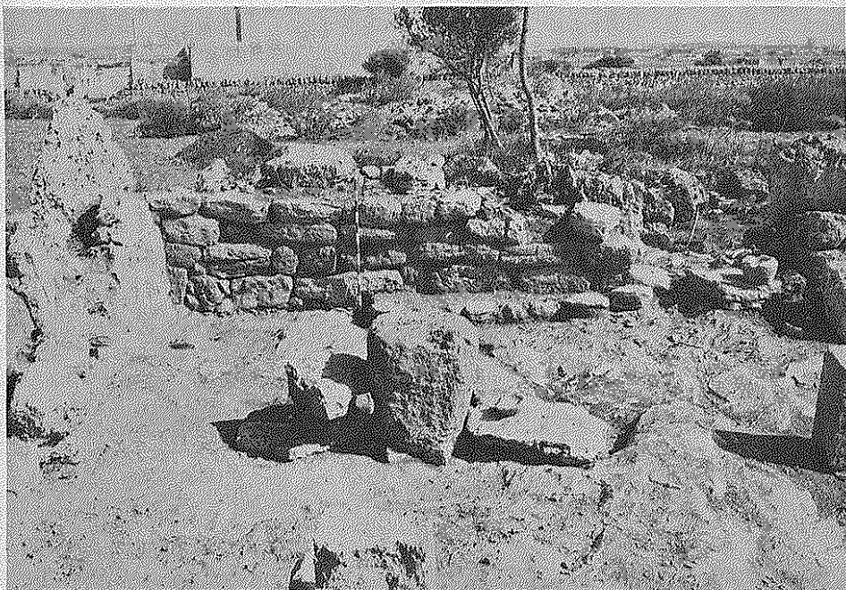
Lámina Vb: Detalle del paramento 4, posible restauración de época romana.
