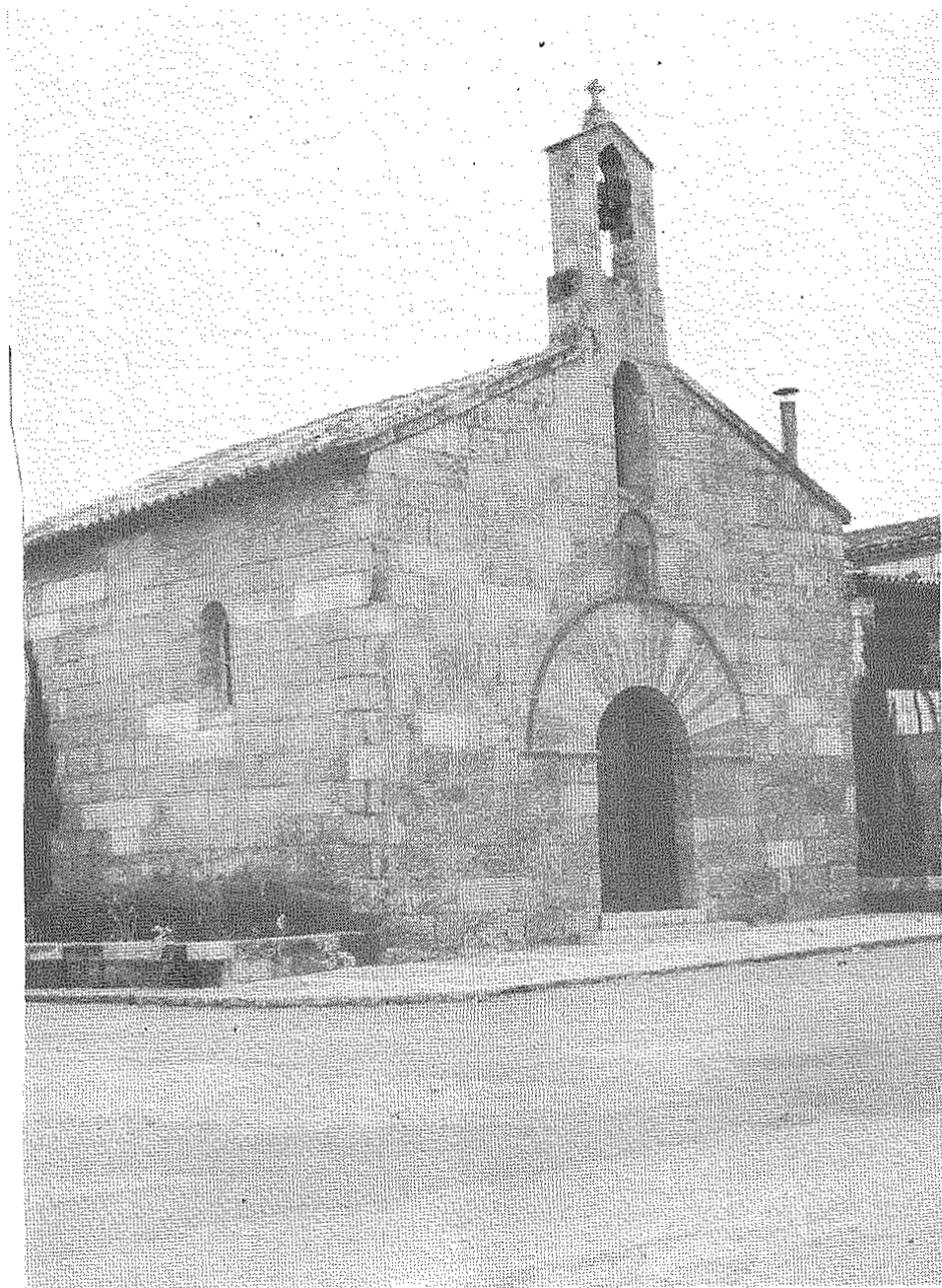
Aspecto exterior de la capilla de la Sang de Muro después de su restauración.
