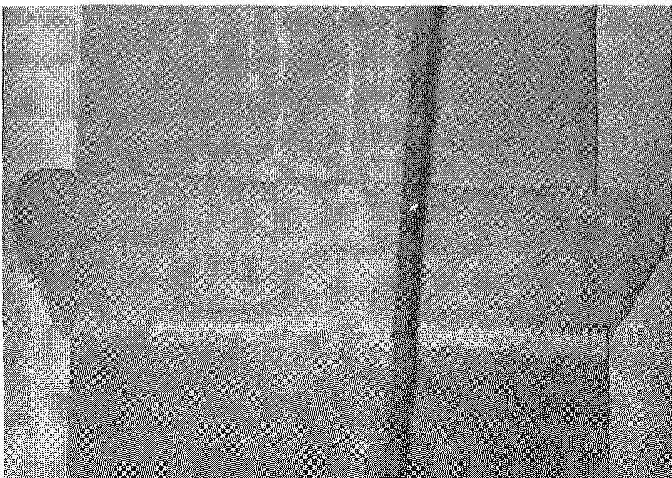
Cornisa de arranque del arco diafragma de la Pau.
