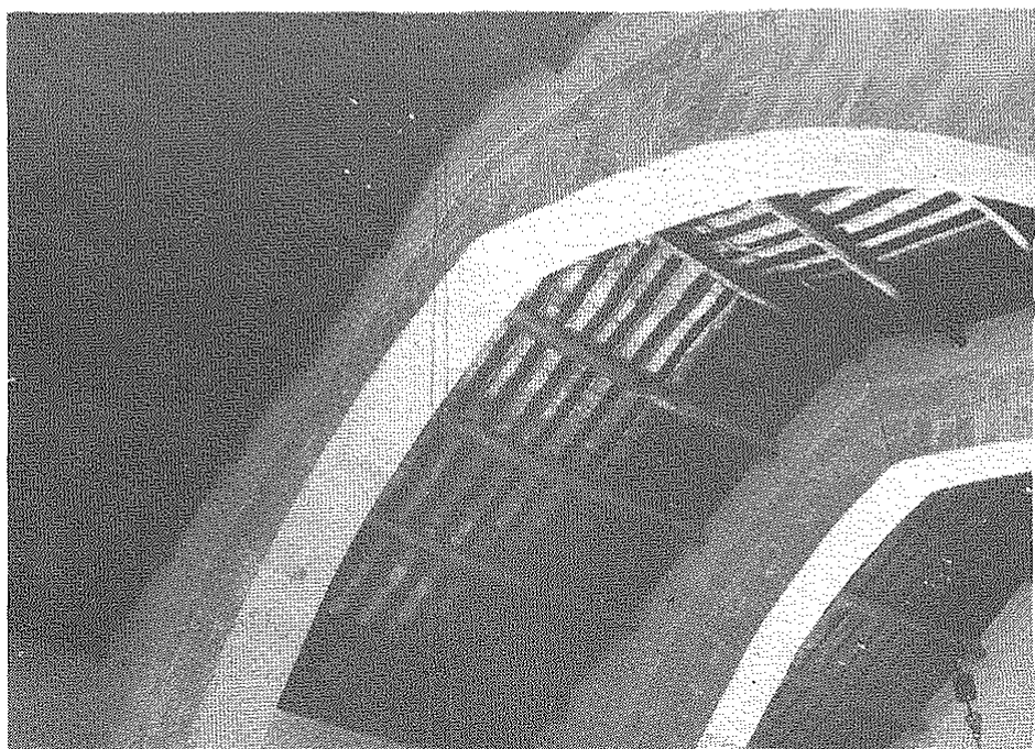
Detalle de los arcos diafragma de la Pau de Castellitx.
