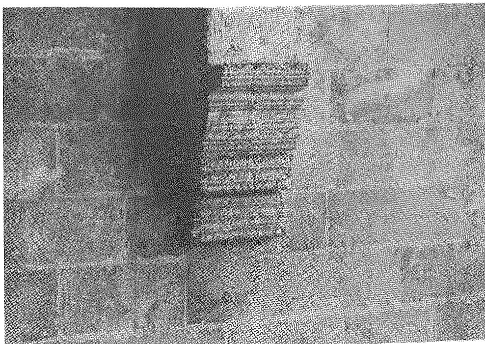
Detalle de las ménsulas de Sta. Margarita.
