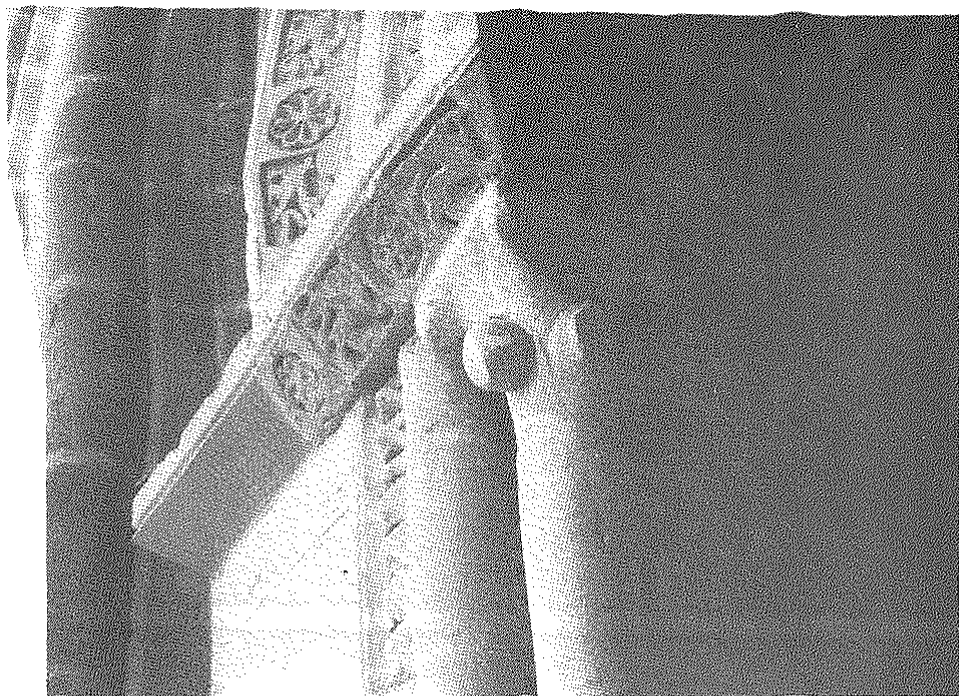
Columnillas de las jambas de las capillas del Temple en Palma.
